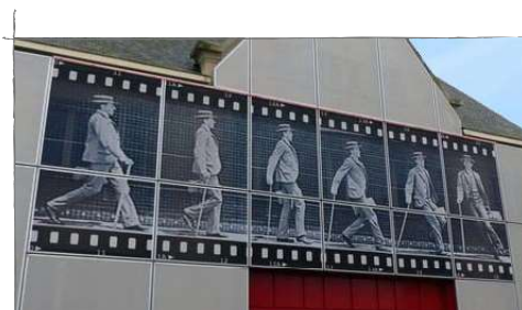
Cinéma Le Vauban - Saint Malo Architecte : Clé Millet International
